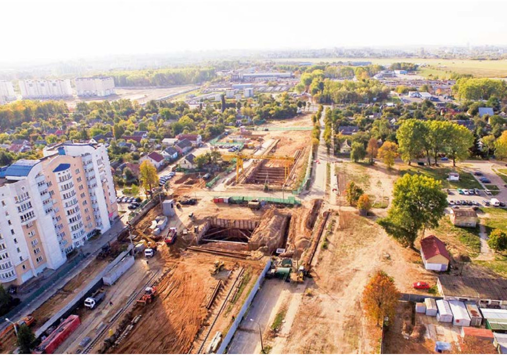
Инженерная подготовка территории на пересечении ул. Жуковского и Аэродромной для строительства 3-й линии метро
